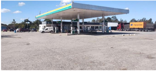
ECOSTATION COMÉRCIO DE COMBUSTÍVEIS LTDA. - Posto 50 (Rodovia RS 040, Km 24, 17610, Águas Claras, Viamão/RS):
